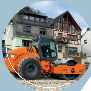
Travaux de terrassement entre voies ferrées et bâtiments historiques à Oberwesel, Allemagne : ici, seul un com- pacteur à oscillation pouvait assurer le compactage requis sans endommager les maisons à colombage ou les installa- tions ferroviaires sensibles.
