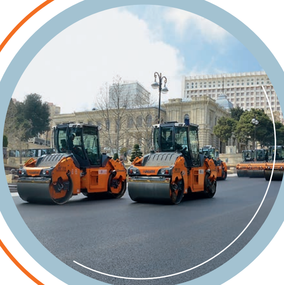
Réalisation du circuit de Formule 1 de Bakou, Azerbaïdjan : lors de la construction du circuit urbain, il a fallu poser un revêtement en enrobé d'une qualité haut de gamme malgré une forte densité d'urbanisation et la présence de parkings souterrains et de canalisations dans le sous-sol. Des conditions qui rendaient la mise en œuvre de compacteurs à oscillation incontournable.
