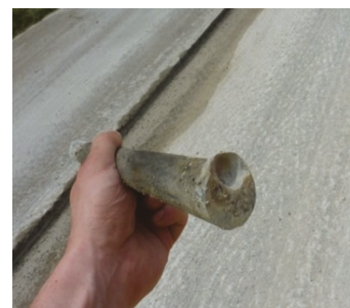
Reforços metálicos no pavimento
