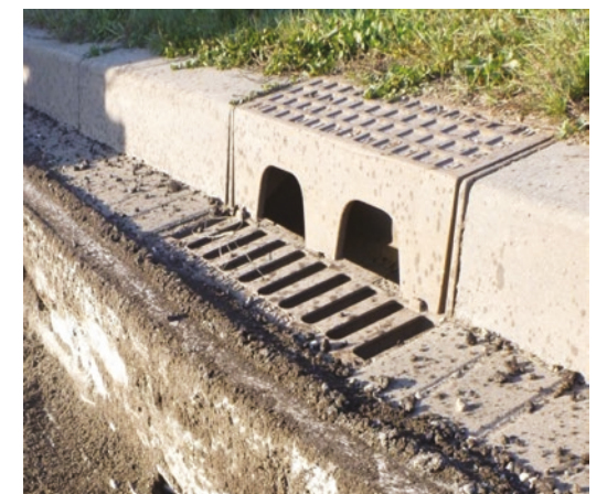
Tapas de alcantarillado
