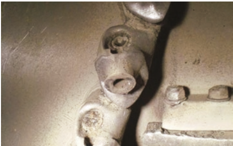
Estado de los soportes
