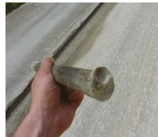
Refuerzos metálicos en el pavimento
