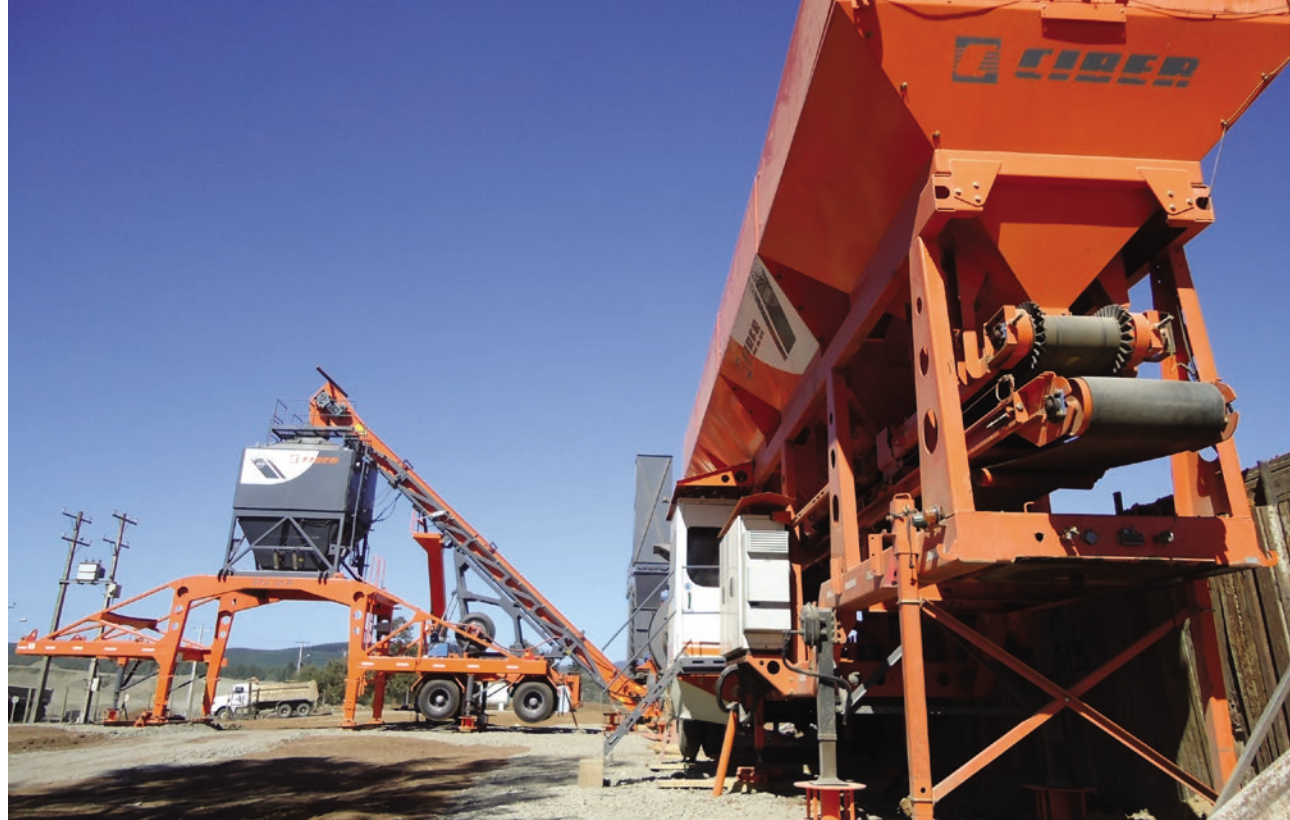
Fotos: Banco de imagens Bitumix CVV
