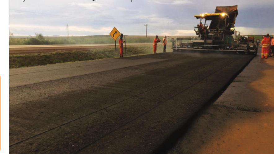
Ejecución de CBUQ en la duplicación
