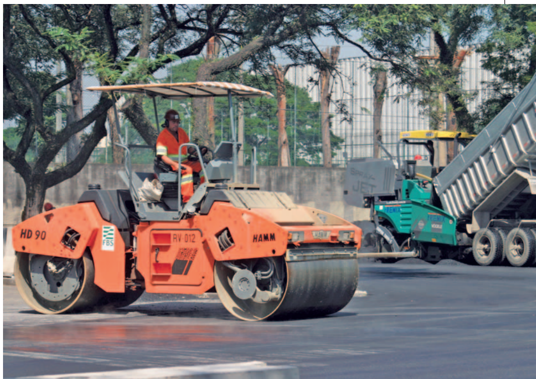
Equipos del Grupo Wirtgen en obras de la Fórmula Indy
