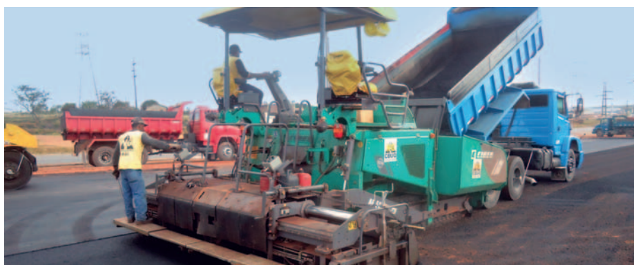
Terminadoras operan en obra del estado de Goiás
