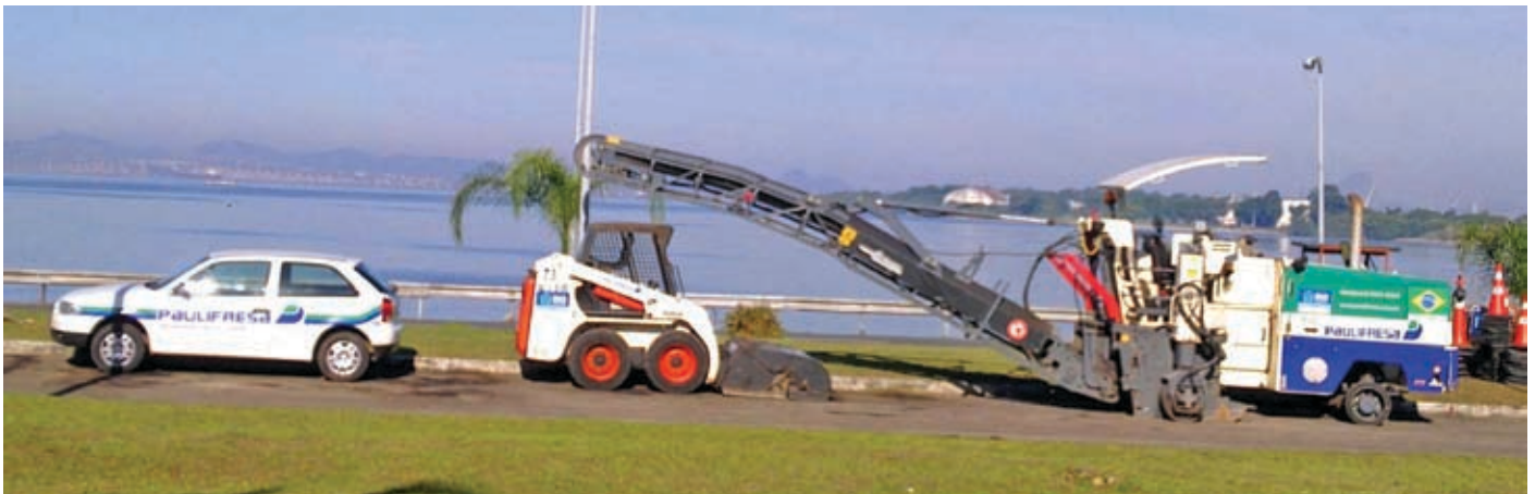
Fresagem no projeto Asfalto Liso, da Prefeitura do Rio de Janeiro
