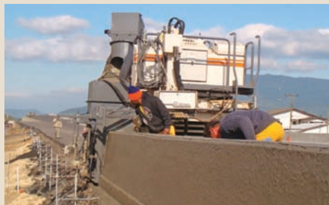
Equipamento em operação na BR-101, na cidade de Terra de Areia
