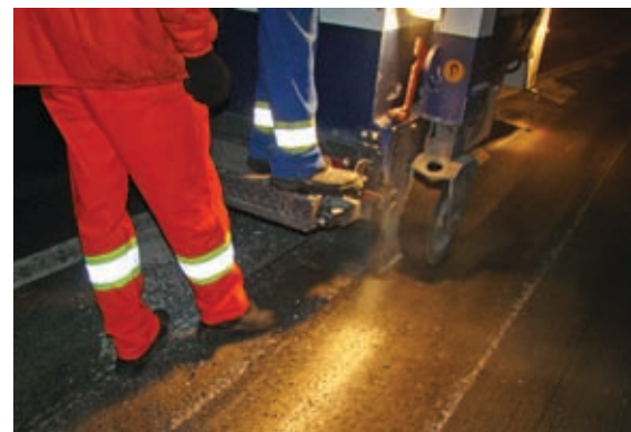
Microfresagem aplicada na Marginal Tietê
