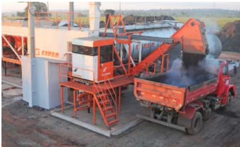
Sob a tutela da Construtora Alvorada, usina já produziu 2 mil toneladas
