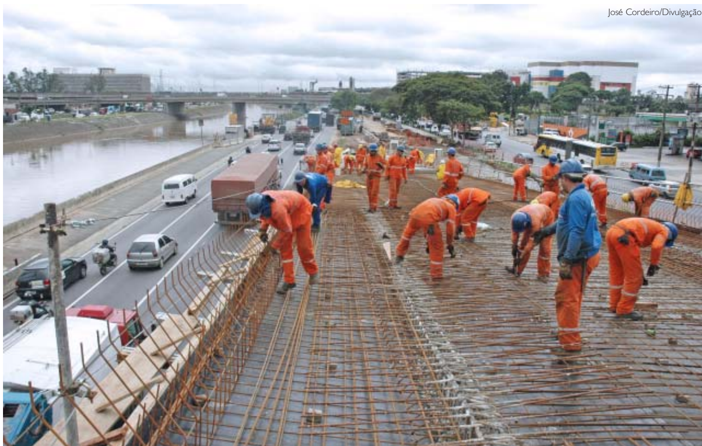
Trecho da Marginal Tietê em obras
