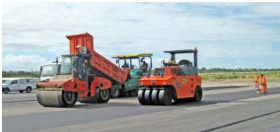
Vögele 1603-2 e três compactadores Hamm na pista do aeroporto de Suazilândia
