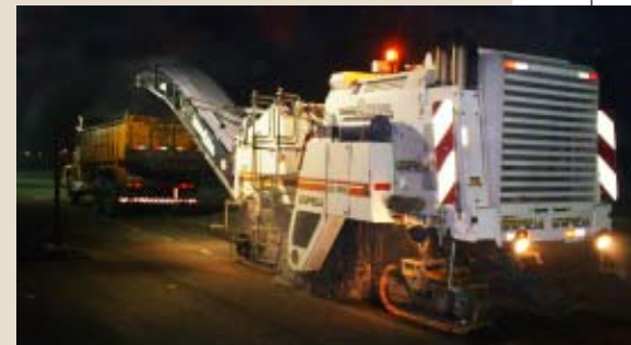
W 1900 realiza fresado fino en el aeropuerto de Porto Alegre
