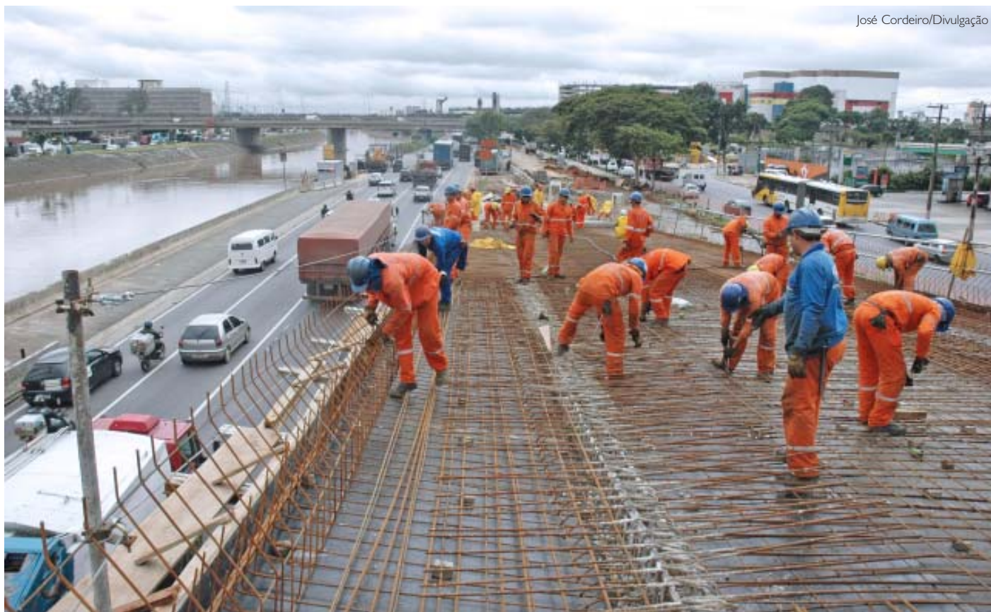
Tramo de la Marginal Tietê en obras
