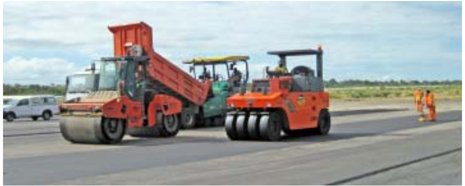
Vögele 1603-2 y tres compactadoras Hamm en la pista del aeropuerto de Suazilandia
