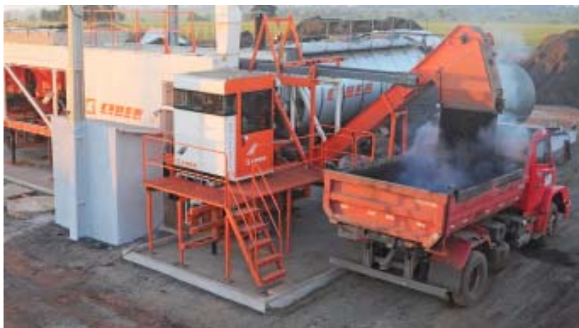
Bajo la tutela de la Constructora Alvorada, la planta ya produjo 2.000 toneladas
