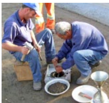
Ensaio de compactação
