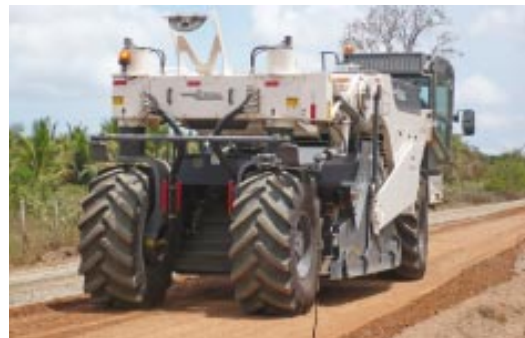
Reciclagem de base na SE-204, no trecho Tatú, em Pacatuba
