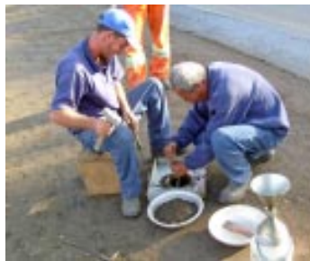
Ensayo de compactación
