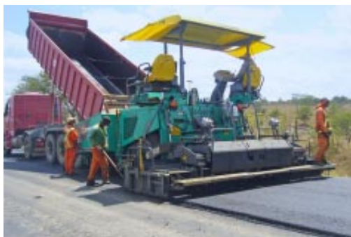
La AF 5500 integra el parque de máquinas de la contratista
