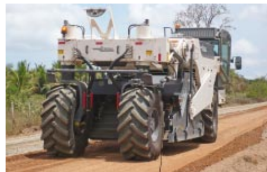
Reciclaje de base en la SE-204, en el tramo Tatú, en Pacatuba
