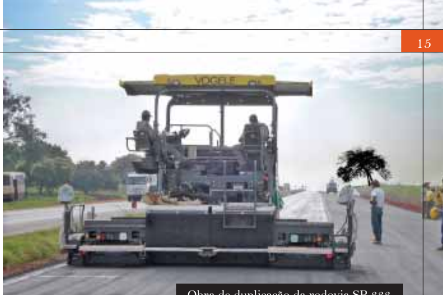
Obra de duplicação da rodovia SP 333
