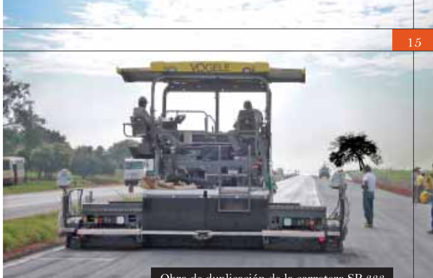
Obra de duplicación de la carretera SP 333
