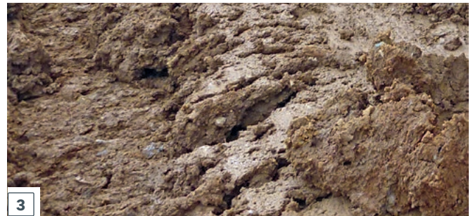
> Suelo altamente cohesivo mezclado con piedras
