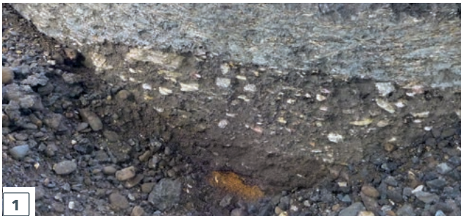
> Capas de asfalto con una capa de grava subyacente
