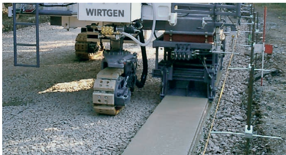
Profil układany na podbudowie tłuczniowej
