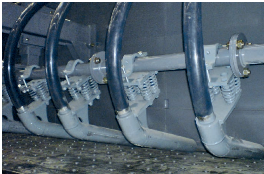
Równomierne rozmieszczenie wibratorów
