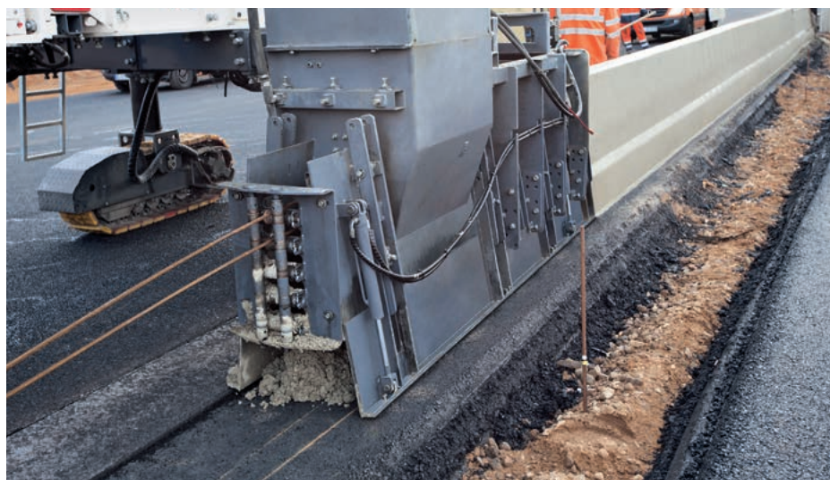
Układanie betonowej ścianki energochłonnej na asfalcie
