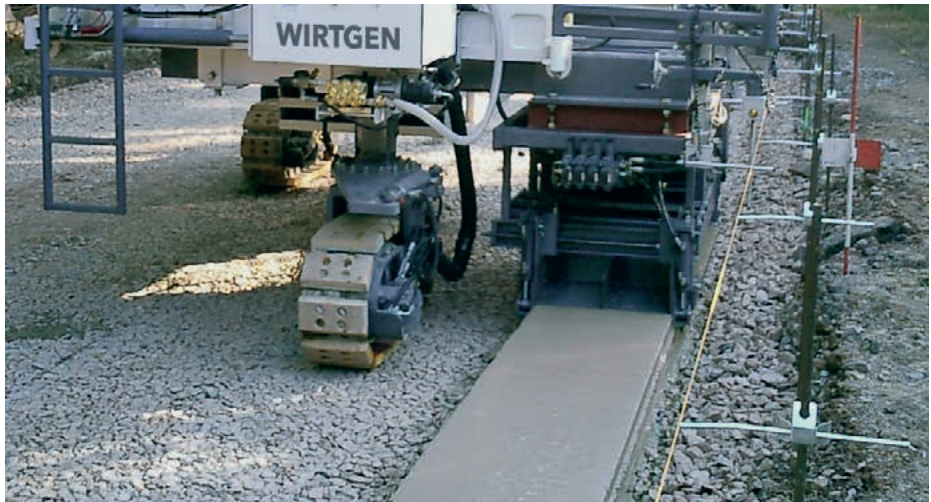
Profileinbau auf Schotter
