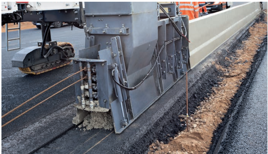
Fertigung einer Betonschutzwand auf Asphalt
