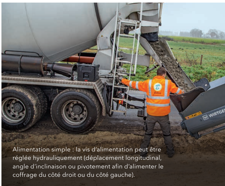
La texture souhaitée de la surface a été obtenue à l'aide de tissu et d'une finition manuelle au balai.
