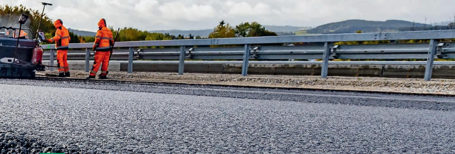
**Sanierung der Autobahn A 93 bei Marktredwitz, Bayern:** Der Raupenfertiger SUPER 3000-3i zeigt seine enormen Qualitäten beim präzisen Einbau der Deckschicht in einer Breite von 11,60 m. Für eine überzeugende Oberflächenqualität sorgte die starre Bohle SB 350. Das Duo vom Marktführer VÖGELE steht für eine maximale Einbaubreite von 18 m und feierte auf der Bauma 2019 in München seine Weltpremiere.
