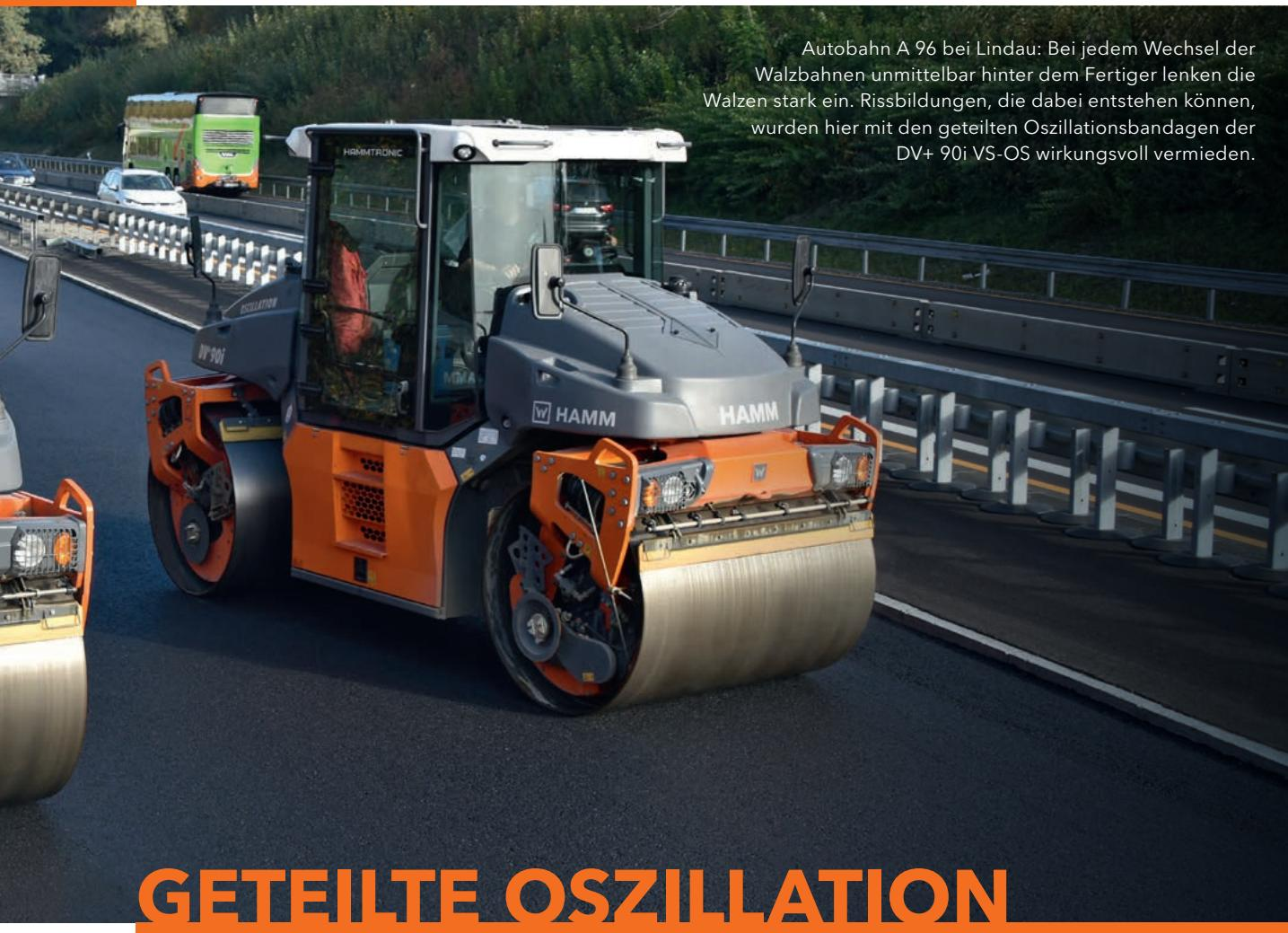
Autobahn A 96 bei Lindau: Bei jedem Wechsel der Walzbahnen unmittelbar hinter dem Fertiger lenken die Walzen stark ein. Rissbildungen, die dabei entstehen können, wurden hier mit den geteilten Oszillationsbandagen der DV+ 90i VS-OS wirkungsvoll vermieden.
