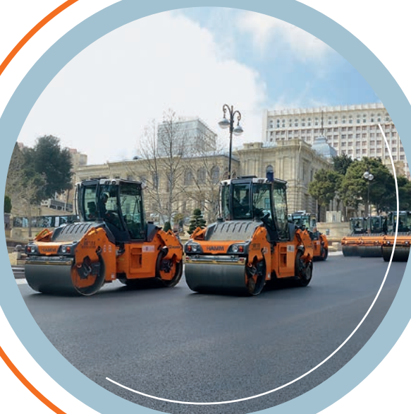
Строительство гоночной трассы для «Формулы-1» в Баку, Азербайджан: при строительстве гоночной трассы требовалось высокое качество асфальтового покрытия несмотря на плотную застройку, подземные паркинги и трубопроводы. Именно поэтому обязательным требованием стало использование осциллирующих катков.
