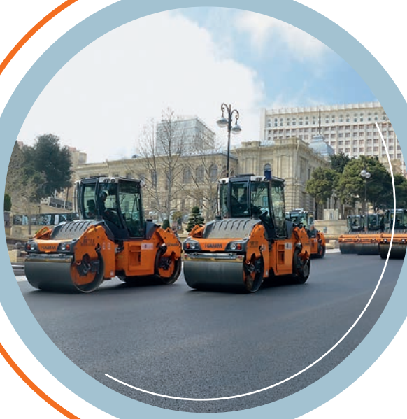
Réalisation du circuit de Formule 1 de Bakou, Azerbaïdjan : lors de la construction du circuit urbain, il a fallu poser un revêtement en enrobé d'une qualité haut de gamme malgré une forte densité d'urbanisation et la présence de parkings souterrains et de canalisations dans le sous-sol. Des conditions qui rendaient la mise en œuvre de compacteurs à oscillation incontournable.
