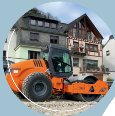
Erdbau zwischen Bahngleis und historischen Bauten in Oberwesel, Deutschland: Hier konnte nur eine Oszillationswalze die geforderte Verdichtung leisten, ohne die Fachwerkhäuser oder die sensiblen Bahnanlagen zu beschädigen.
