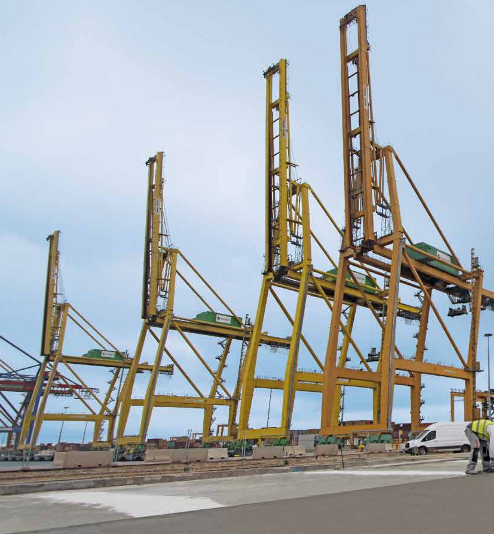
La nueva generación de extendedoras de hormigón WIRTGEN se pone en marcha: Una SP 64i (aquí en la foto) crea una solución estable en el puerto de Valencia, España. El primer proyecto para una SP 94i fue la rehabilitación de una pista de despegue y aterrizaje del Jefferson City Memorial Airport en Missouri, EE.UU.
