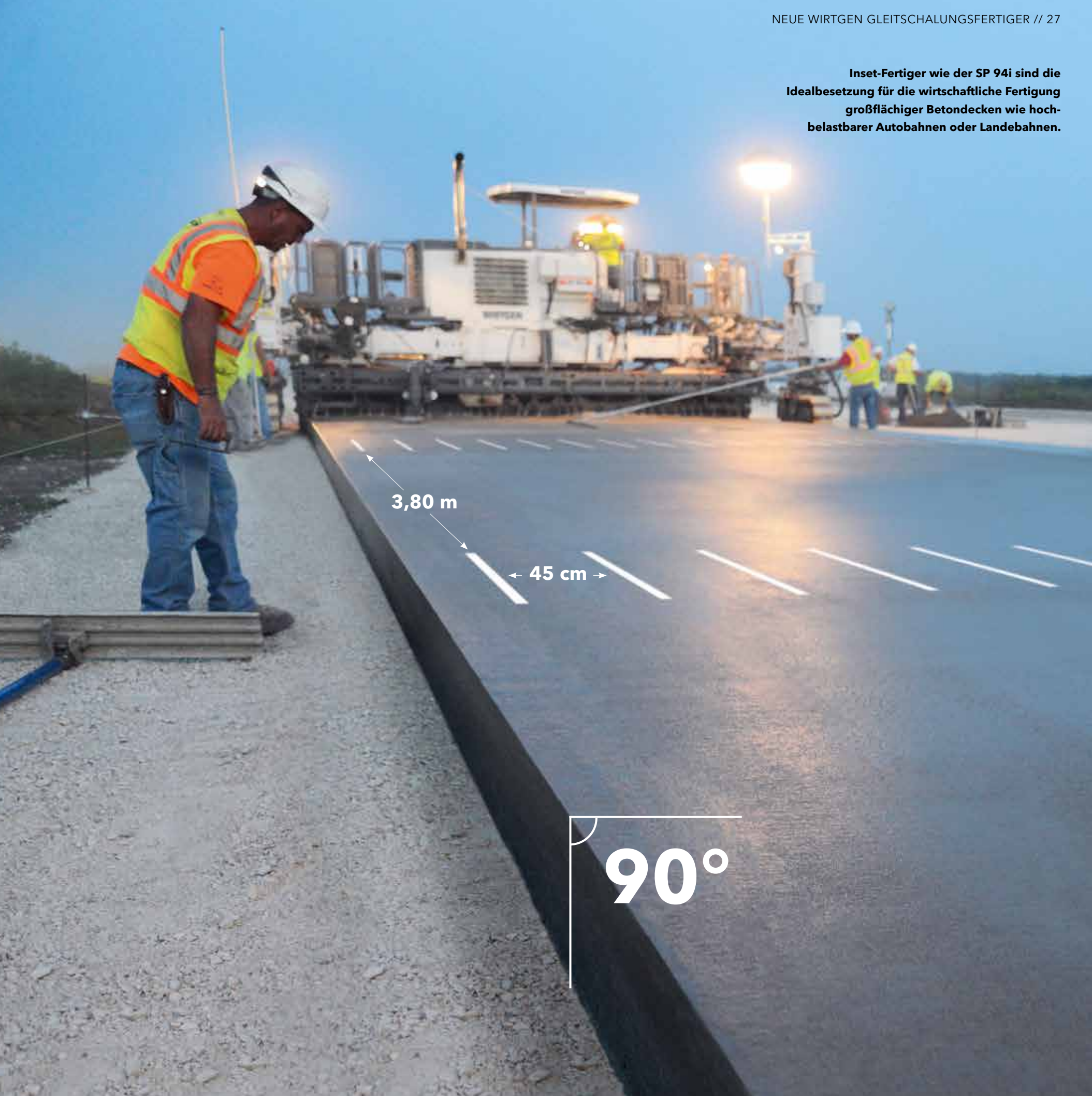
Längsfugenankersetzer: Die automatisch eingesetzten Längsfugenanker verhindern das Auseinanderwandern von Fahrbahnen.
