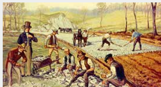
1822: первое дорожное покрытие типа «Макадам» в Мэриленде (США).
