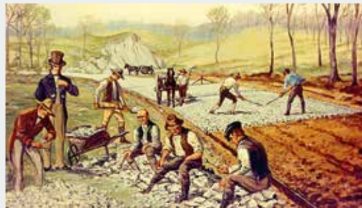
1822: la construcción de la primera carretera con estilo macadán en Maryland (EE. UU.).
