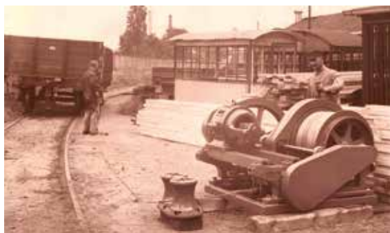
En 1925, una mesa de transferencia de Vögele en el puerto de Mannheim unió entre sí las vías que discurrían en paralelo y permitió así el intercambio de locomotoras.
