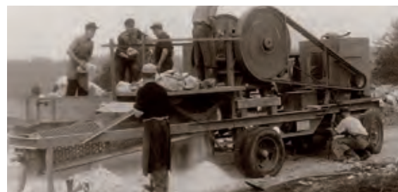
In den 1950er-Jahren entwickelte Kleemann die ersten radmobilen Backenbrecher mit Trommelsieb.
