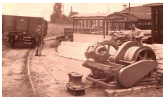
Eine Schiebebühne von Vögele 1925 im Mannheimer Hafen verband die parallel verlaufenden Gleise miteinander und ermöglichte so einen Austausch der Lokomotiven.
