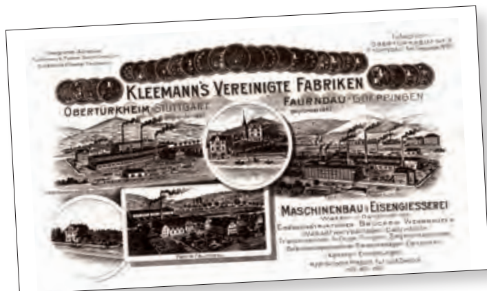
1902 entstanden die „Kleemanns Vereinigte Fabriken in Obertürkheim und Faurndau“.
