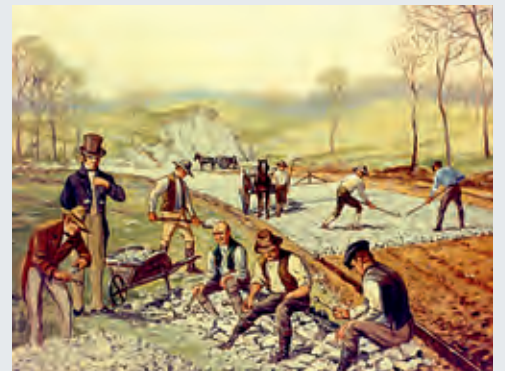
1822: Der erste Straßenbau in Makadam-Bauweise in Maryland (USA).
