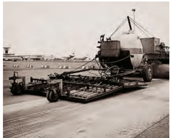
Warmfräse SF 3800 im Einsatz auf dem Flughafen Düsseldorf 1973.
