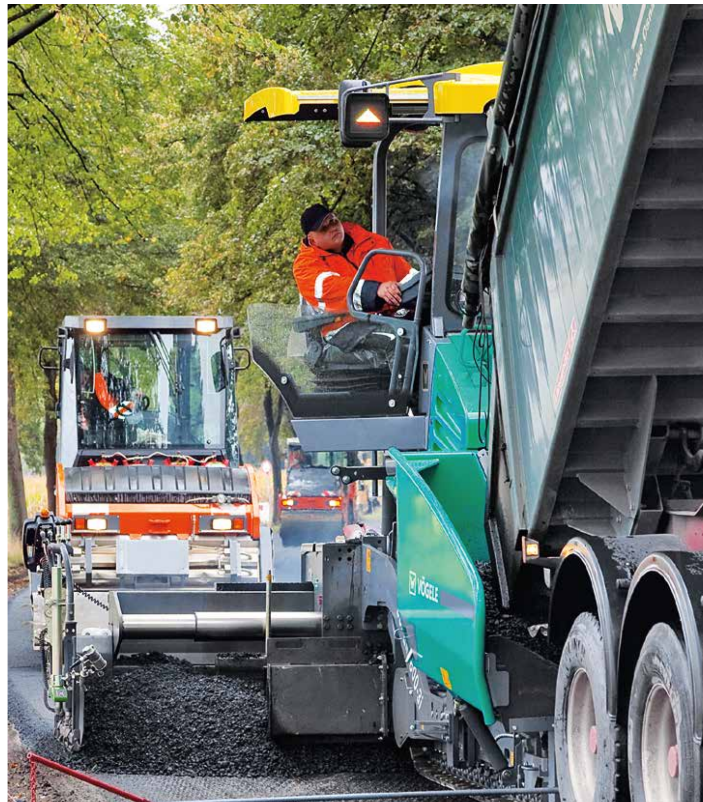
Dass auf Vögele Hamm folgt, hat sich bei der Deckschichtsanierung und allgemein im Straßenbau bewährt.
