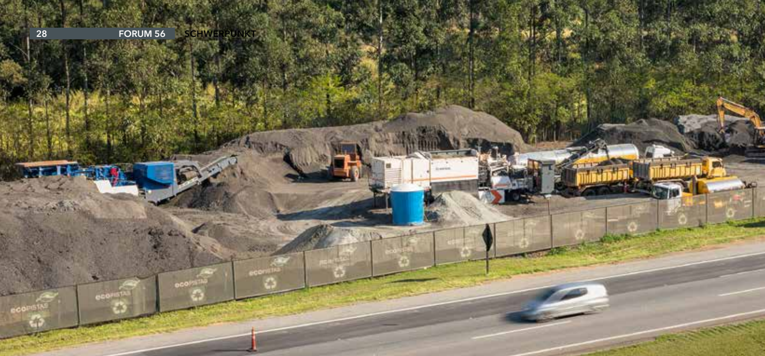
Aufbau der Kaltrecycling Mischanlage und des Brechers erfolgt in unmittelbarer Nähe zur Baustelle.
