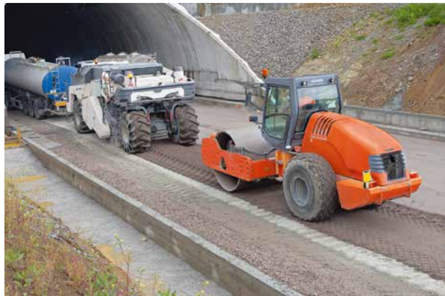
Der Kaltrecycling-Zug aus Tankwagen, Kaltrecycler WR 240 und Hamm Walze hinterlässt eine stabile Oberfläche, die bei Bedarf auch ohne neue Deckschicht für den Verkehr freigegeben werden kann.
