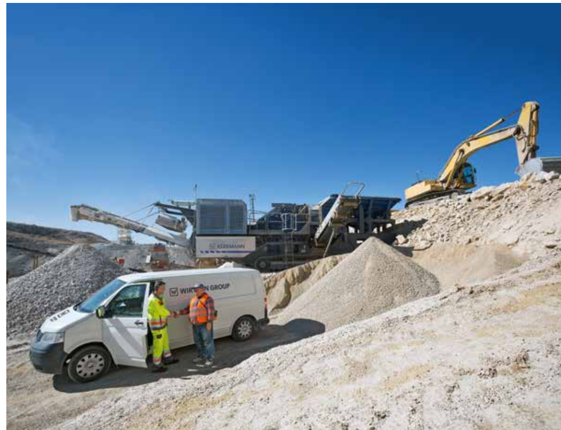
Fachkundige und schnelle Hilfe gibt Sicherheit im Baustellenalltag.
