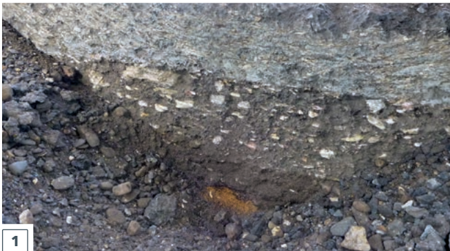
> Strati di asfalto con strato di ghiaia sottostante
