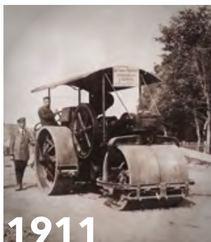
1911 HAMM construit le premier compacteur d'enrobé à moteur diesel.
