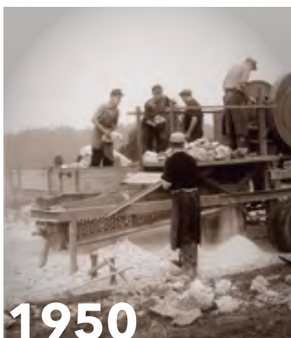
1950 Concasseur à mâchoire mobile sur roues à alimentation manuelle et crible à tambour de KLEEMANN.
