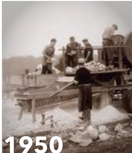
Machacadora de mandíbulas sobre ruedas, de carga manual y con tambor cribador de KLEEMANN.
