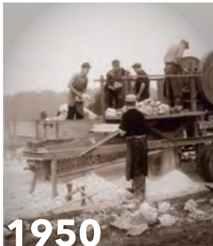
Handbeschickter, radmobiler Backenbrecher mit Trommelsieb von KLEEMANN.
