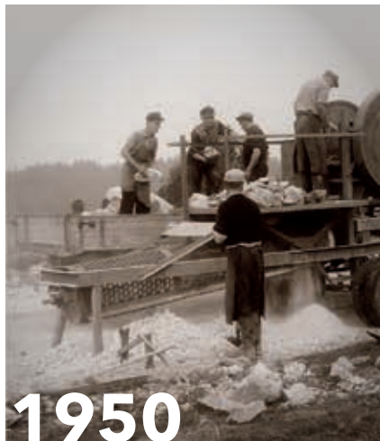
Handbeschiekter, radmobiler Backenbrecher mit Trommelsieb von KLEEMANN.
