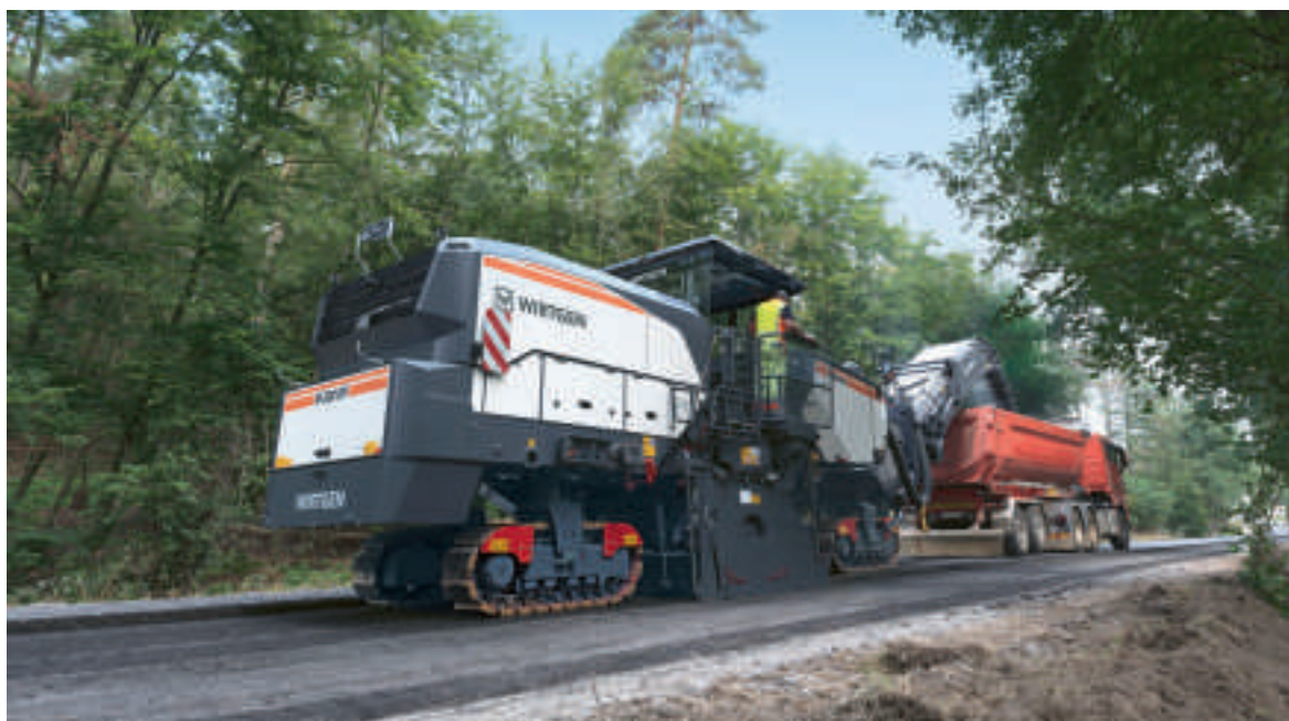
Grandes fraiseuses pour le fraisage de grandes surfaces sur une profondeur allant jusqu'à 35 cm et en une seule opération.
