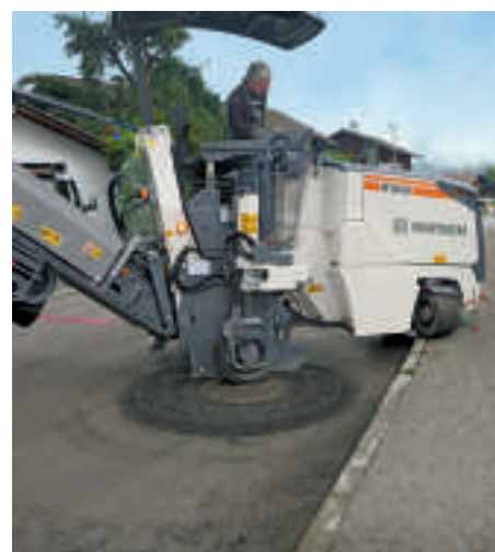
Fraisage autour d'obstacles tels que des plaques d'égout avec les petites fraiseuses maniables.
