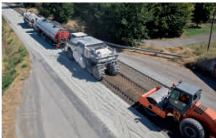
Réalisation d'une couche portante neuve de haute qualité avec le WR 240 (i) de la série WR.
