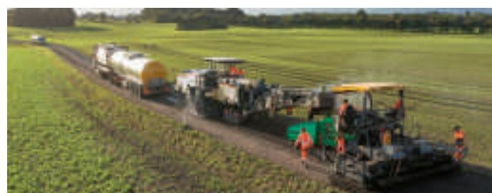
Le W 380 CR (i) de la série CR lors du recyclage à froid sur site d'une chaussée, en une seule opération.
