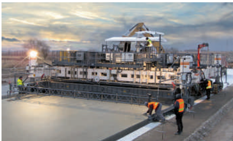
Pose d'un revêtement routier en béton à une ou deux couches sur une largeur allant jusqu'à 16 m, avec la machine à coffrage glissant SP 164.
