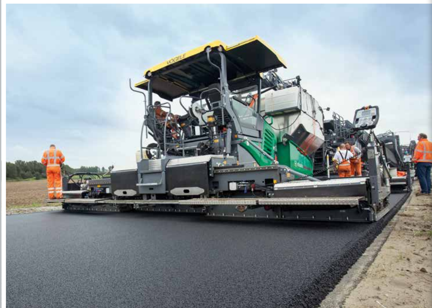
Durch das Eigennivellierverhalten der beiden Fertiger wird bei InLine Pave ein Höchstmaß an Ebenheit erreicht.
