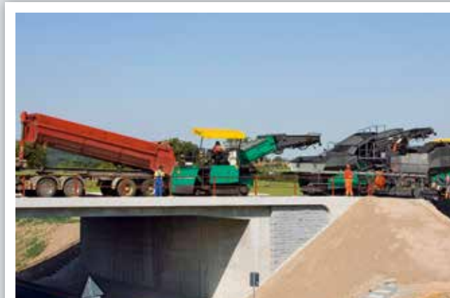
Neubau einer Bundesstraße, Einbaubreite 7,50 m: Zweischichtiger Einbau zwischen insgesamt 6 Brückenbauwerken. Die Brücken wurden nur vom Deckenfertiger mit Deckschichtmaterial überbaut. Nivellierung unter Nutzung des Big-MultiPlex-Skis.
