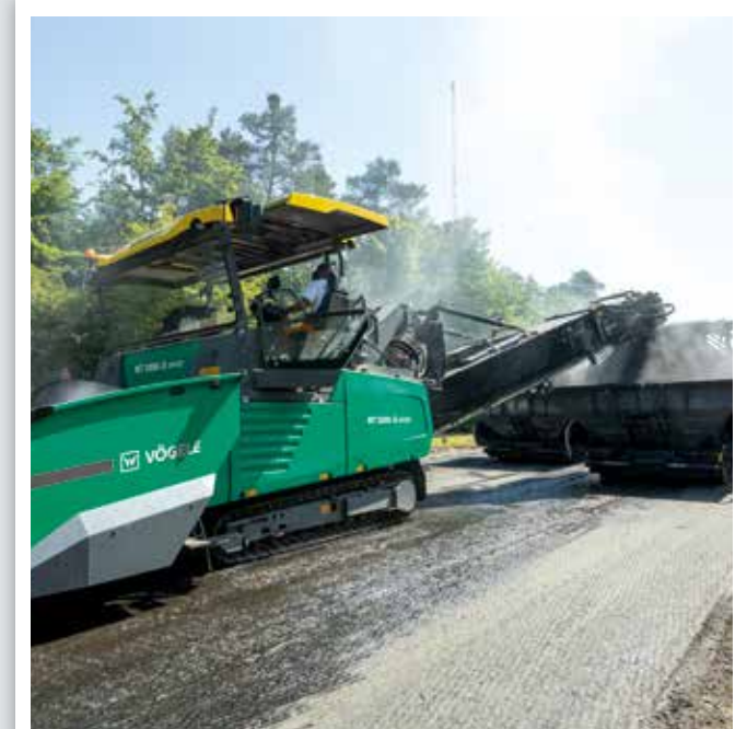
Der Beschickerfahrer hat eine freie, unverbaute Sicht auf die Mischgut-LKWs sowie auf den SUPER 2100-3i IP.
