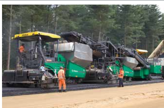
Neubau einer Autobahn, Einbaubreite 5,00 m: Zusätzlich zu Binder- und Deckschicht wurde die Tragschicht mit dem SUPER 2100-2 IP eingebaut.
