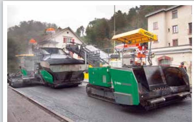
Sanierung einer Landstraße, variierende Einbaubreiten von 5,50 - 7,00 m: Einbau von 9,5 cm Binder- und 2,5 cm dicker Deckschicht in 12-Stunden-Schichten – für den Einbauszug eine Kleinigkeit.
