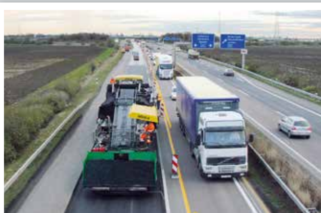
Sanierung einer Autobahn, Einbaubreite 4,00 m: Einspurige Sanierung der Lastspur unter fließendem Verkehr.
