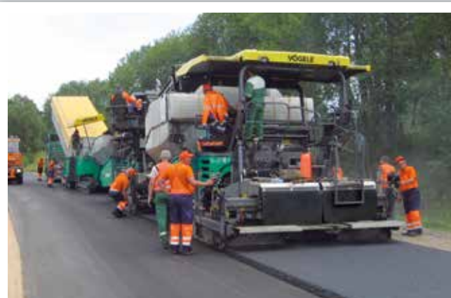
Sanierung einer Nationalstraße, Einbaubreite 3,75 - 5,25 m: Halbseitige Sanierung unter fließendem Verkehr mit 2 % Querneigung. Abtasten eines abgefrästen Untergrunds mit Big-MultiPlex-Ski ermöglicht Einbau in höchster Ebenheit.
