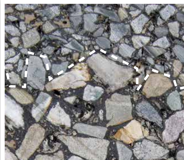
Hervorragende Verklebung und Verzahnung von Binder- und Deckschicht.
