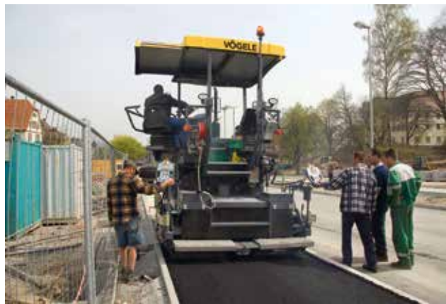
POSE D'ENROBÉ SUR TROTTOIRS/PISTES CYCLABLES COMBINÉS
