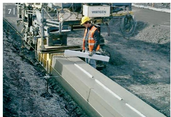
7 | Incorporación de una cuneta de ranura para el desague de aguas pluviales.
