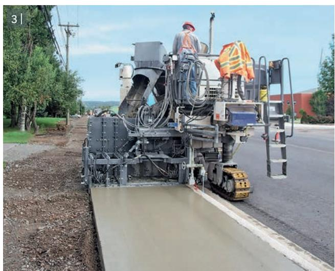
3 | Producción de veredas y carriles para bicicletas de hasta 1,8 m de ancho, en este caso, con un encofrado ampliable de forma modular.
