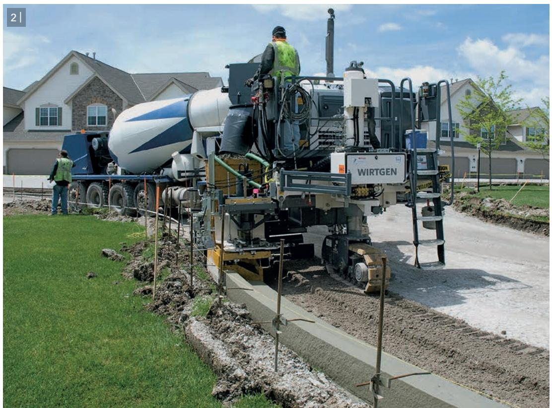
**1 |** Extendido de la franja de un bordillo dispuesto de forma inclinada.
