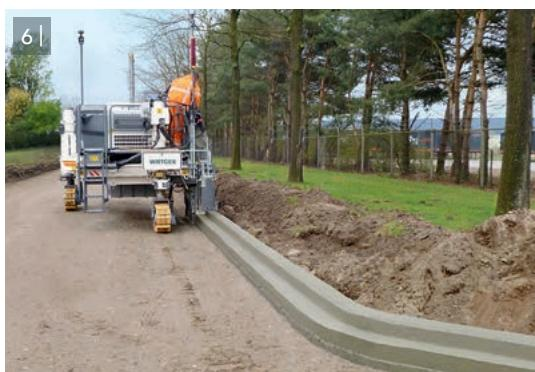
6 | Producción precisa de perfiles de bordillos y canales mediante AutoPilot 2.0.
