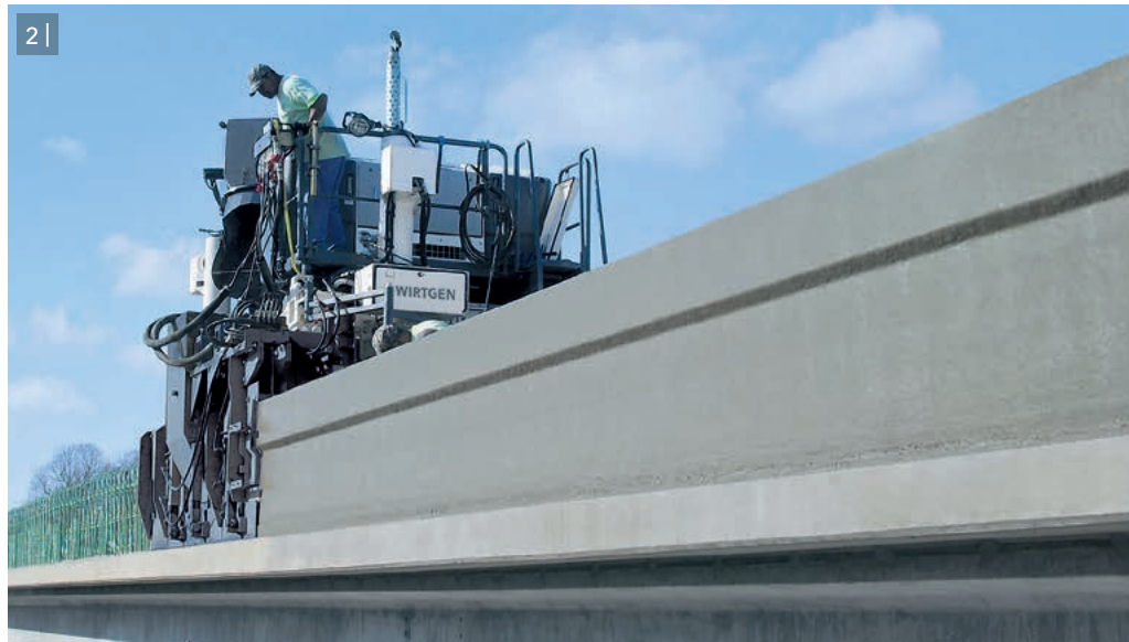
2 | ... als auch links-seitiger Einbau von Betonschutzwänden mit durchgehender Bewehrung.
