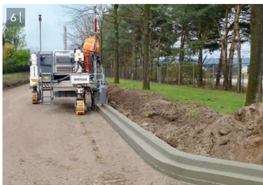
6 | Präzise Herstellung von Bordstein-/Rinnenprofilen mittels AutoPilot 2.0.
