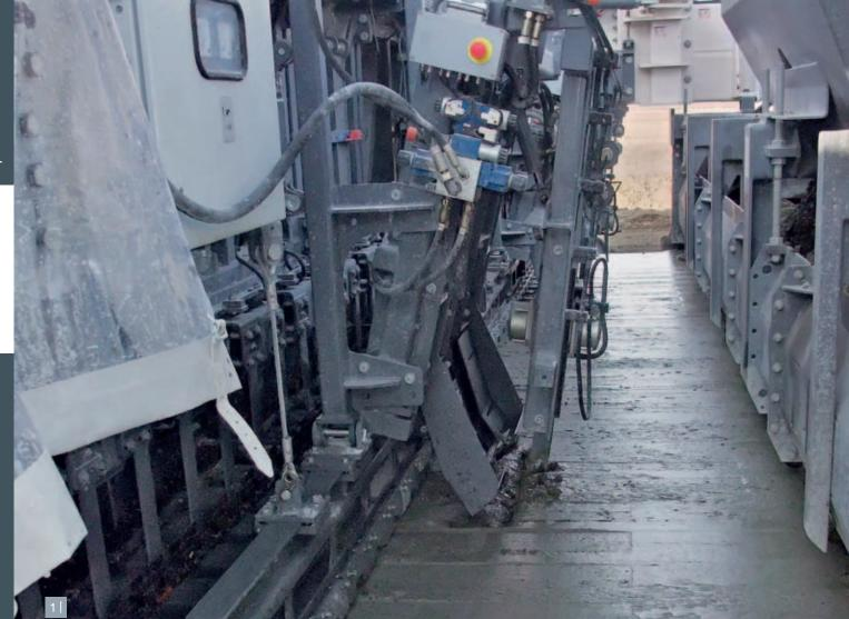
1 | Les barres de liaison insérées par l'inserteur de barres de liaison empêchent les bandes de s'écarter les unes des autres.
