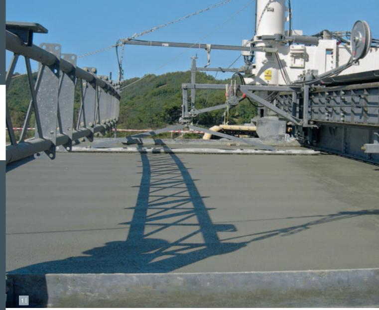
1 | La taloche longitudinale en matériau haut de gamme produit une surface parfaitement lisse.
