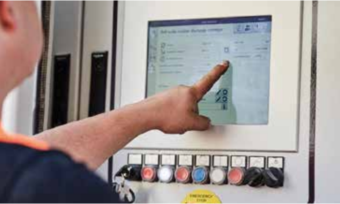
> Dar a ordem de "Bloquear rotor" através de SPECTIVE
