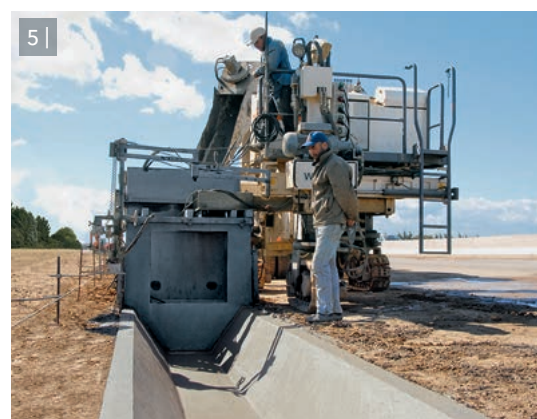
3 | 采用模块化、伸缩式滑模摊铺机摊铺宽达 1.8 m 的人行道和自行车道。
