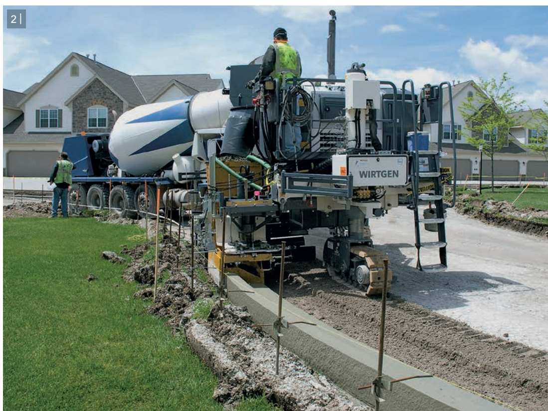
1 | 混凝土硬路肩的滑模摊铺。
