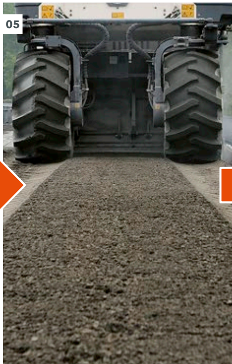
04-06 冷再生施工中，强劲的铣刨和拌合转子铣刨受损路面。破碎后的材料与喷入的粘结剂高效拌合，生成均匀的再生混合料，直接用于摊铺和压实。
