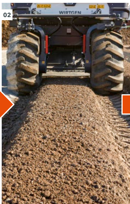
01-03 土壤稳定施工，能够将承载力不足的土壤就地转换为优质的筑路材料，直接用于摊铺和压实。
