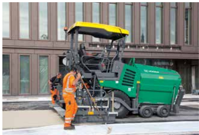
EXTENDIDO DE ASFALTO EN SUPERFICIES UTILIZADAS INDUSTRIALMENTE
