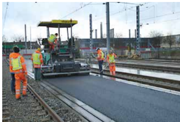
EXTENDIDO DE ASFALTO EN ANDENES
