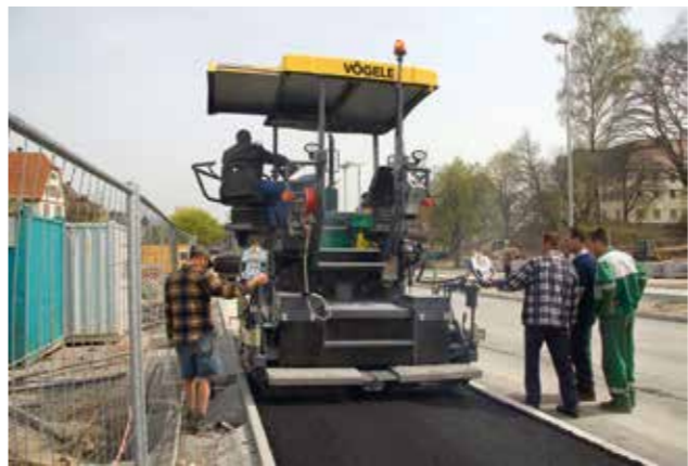
EXTENDIDO DE ASFALTO EN COMBINACIONES DE VÍAS PEATONALES Y CARRILES-BICI
