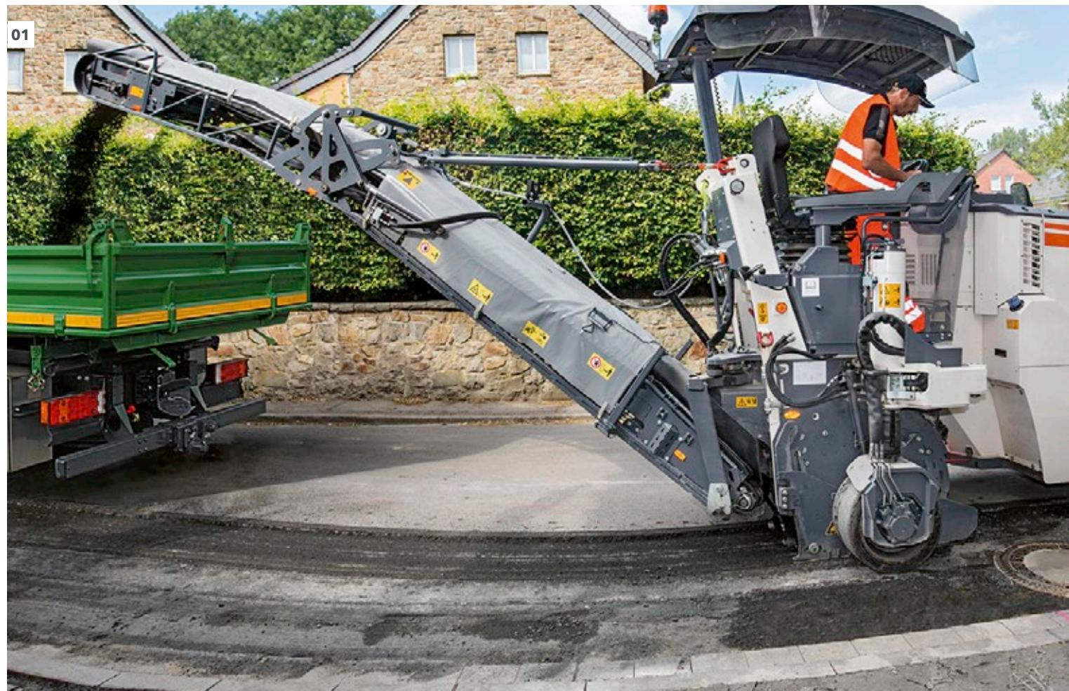
**01** Малая фреза гарантирует эффективную погрузку с фрезерованного материала.
