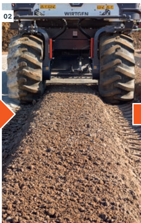
01 - 03 Nella stabilizzazione, il sottofondo non sufficientemente portante viene trasformato in un terreno ben stendibile e compattabile.
