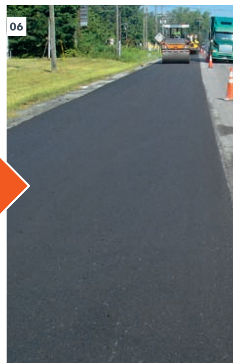
04 - 06 Nel riciclaggio a freddo, gli strati di asfalto ammalorati vengono granulati, miscelati con il legante, trattati, compattati e stesi nuovamente.
