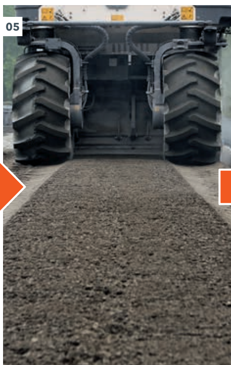
04 - 06 Nel riciclaggio a freddo, gli strati di asfalto ammalorati vengono granulati, miscelati con il legante, trattati, compattati e stesi nuovamente.
