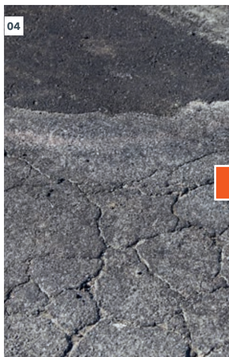
04 - 06 Nel riciclaggio a freddo, gli strati di asfalto ammalorati vengono granulati, miscelati con il legante, trattati, compattati e stesi nuovamente.
