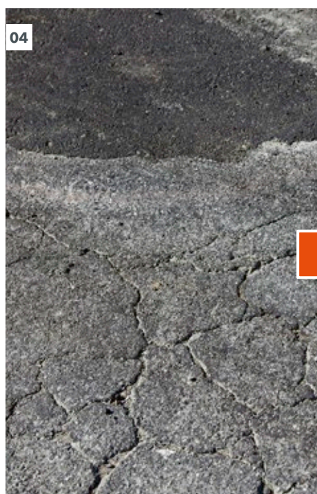
04 - 06 Le recyclage à froid consiste à granuler les couches d'asphalte endommagées, à les mélanger à un produit de cure, à les préparer, à les compacter et à les poser.
