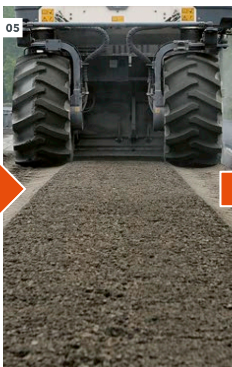
04 - 06 Le recyclage à froid consiste à granuler les couches d'asphalte endommagées, à les mélanger à un produit de cure, à les préparer, à les compacter et à les poser.
