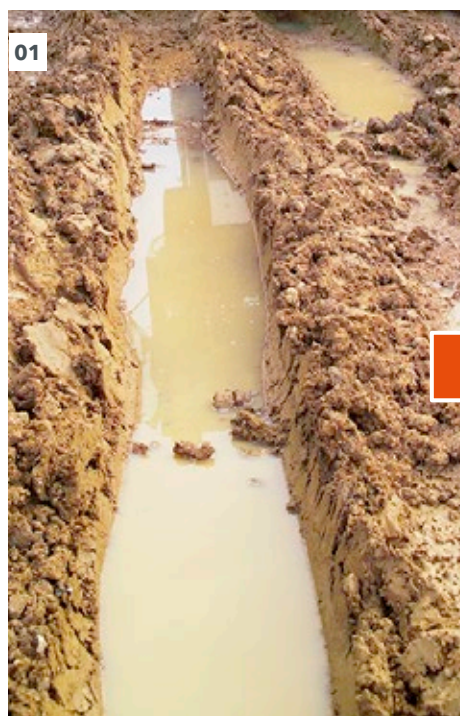
01 - 03 Lors de la stabilisation, des sols supports insuffisamment portants sont transformés en sols facilement intégrables et compactables.
