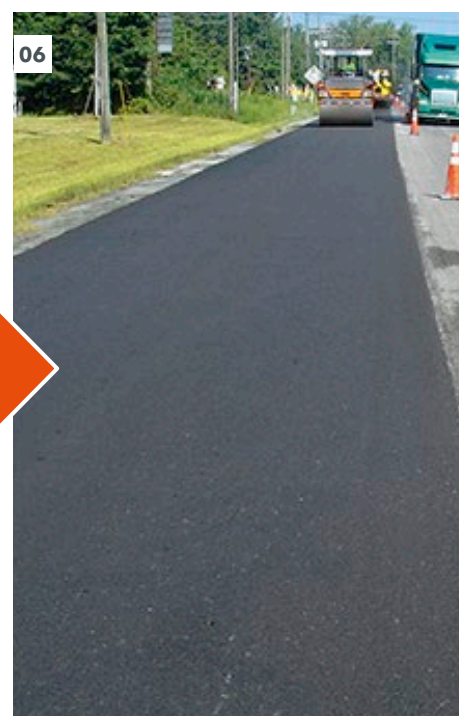
04 - 06 Le recyclage à froid consiste à granuler les couches d'asphalte endommagées, à les mélanger à un produit de cure, à les préparer, à les compacter et à les poser.
