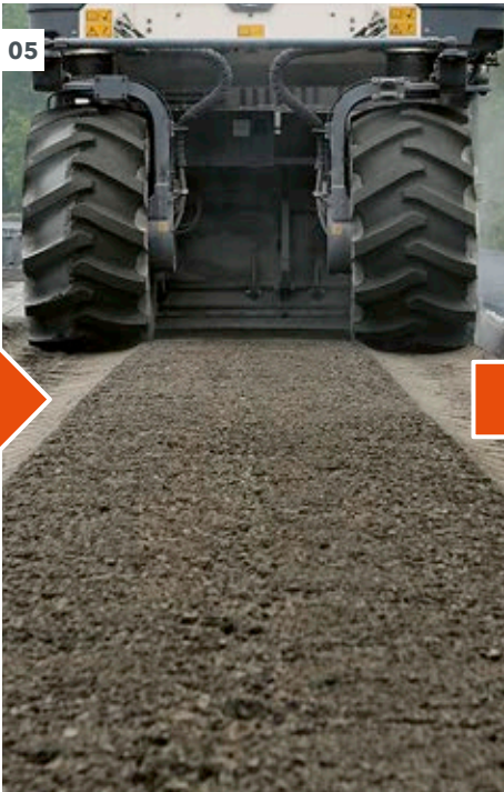
04 - 06 Durante el reciclaje en frío se granulan capas de asfalto dañadas, se mezclan con aglutinante, se tratan, se compactan y se vuelven a extender.
