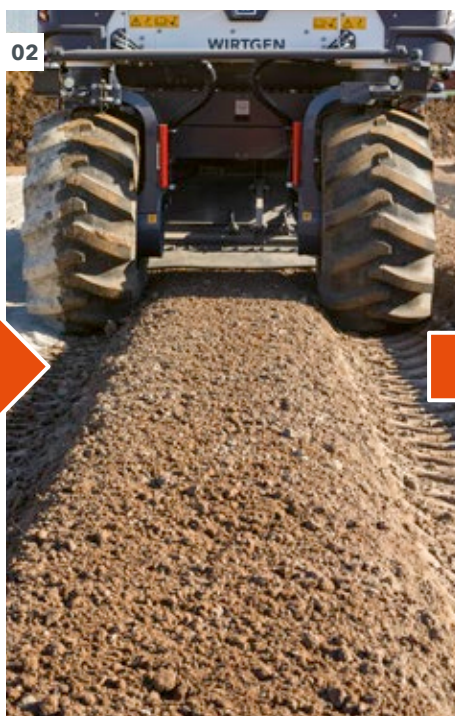
01 - 03 Durante la estabilización, el subsuelo con una capacidad de carga insuficiente se transforma en un suelo apto para el extendido y la compactación.
