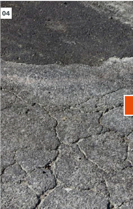
04 - 06 Durante el reciclaje en frío se granulan capas de asfalto dañadas, se mezclan con aglutinante, se tratan, se compactan y se vuelven a extender.
