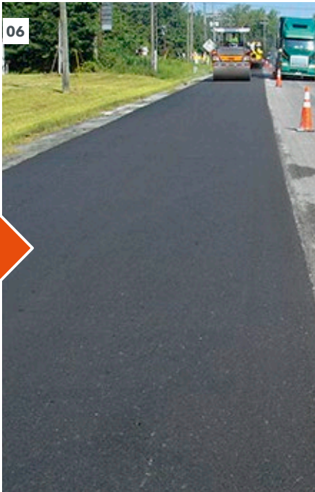
04 - 06 Durante el reciclaje en frío se granulan capas de asfalto dañadas, se mezclan con aglutinante, se tratan, se compactan y se vuelven a extender.
