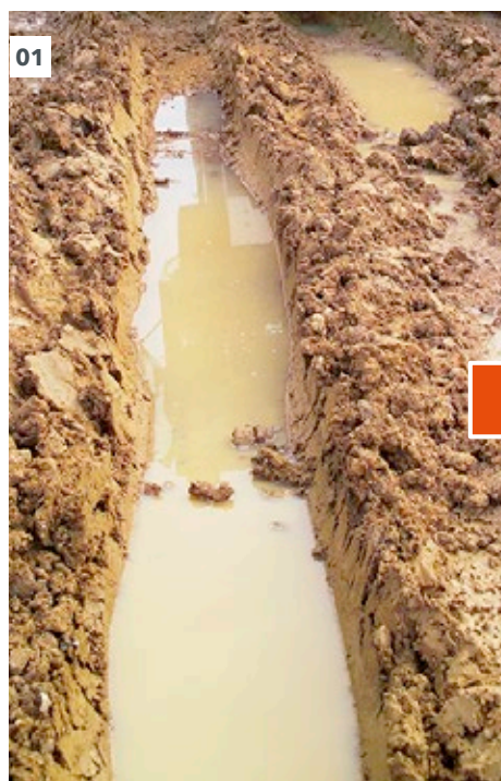
01 - 03 Durante la estabilización, el subsuelo con una capacidad de carga insuficiente se transforma en un suelo apto para el extendido y la compactación.
