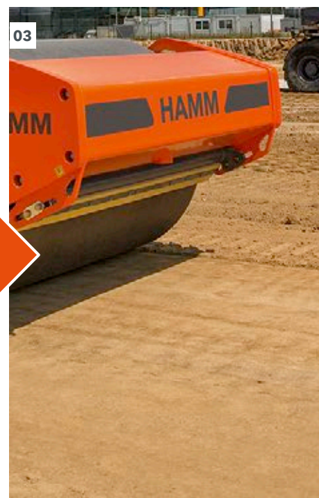
01 - 03 Durante la estabilización, el subsuelo con una capacidad de carga insuficiente se transforma en un suelo apto para el extendido y la compactación.
