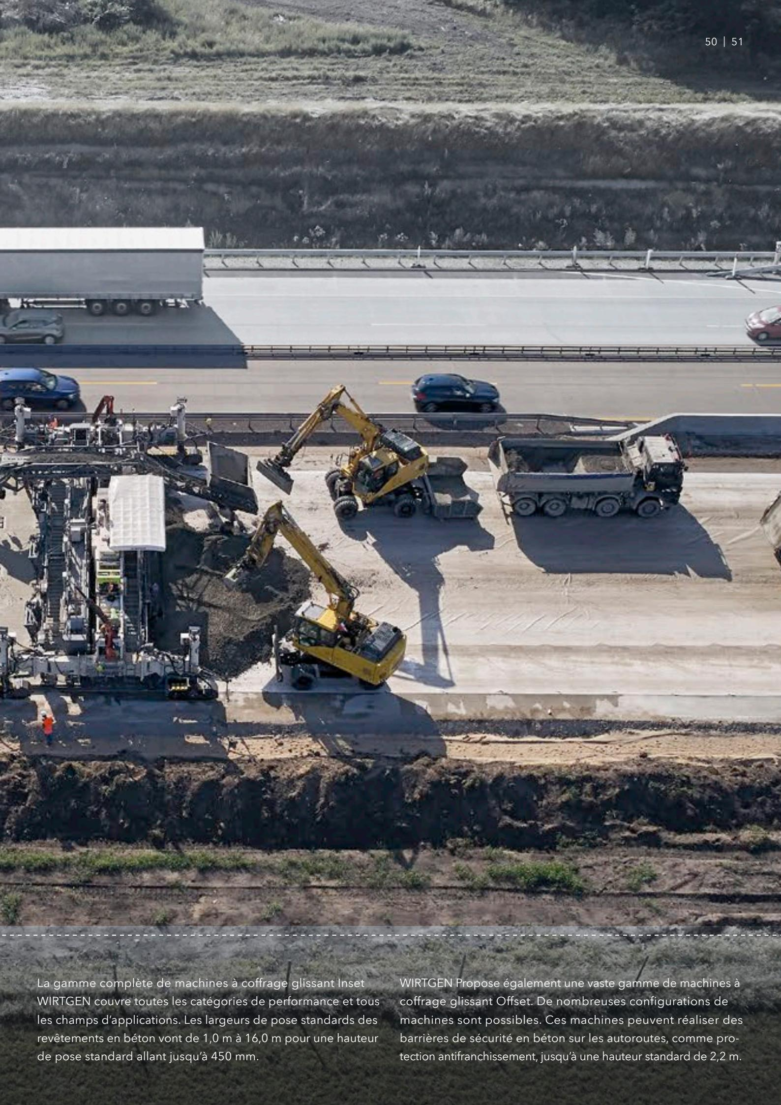
La gamme complète de machines à coffrage glissant Inset WIRTGEN couvre toutes les catégories de performance et tous les champs d'applications. Les largeurs de pose standards des revêtements en béton vont de 1,0 m à 16,0 m pour une hauteur de pose standard allant jusqu'à 450 mm.
