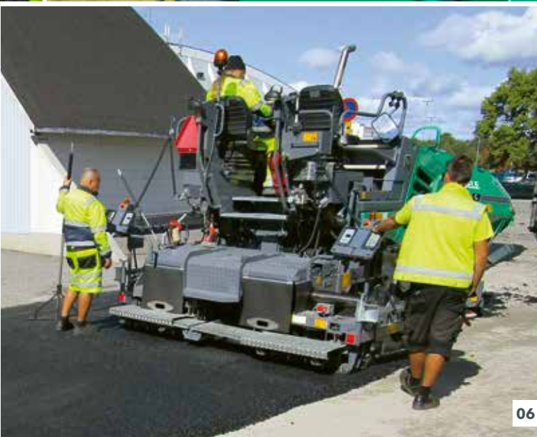
04 La plataforma del operador de la extendedora garantiza la máxima visibilidad. 05 Alimentación óptima con mezcla gracias a la gran tolva de material. 06 Puede combinarse con la regla extensible AB 340.
