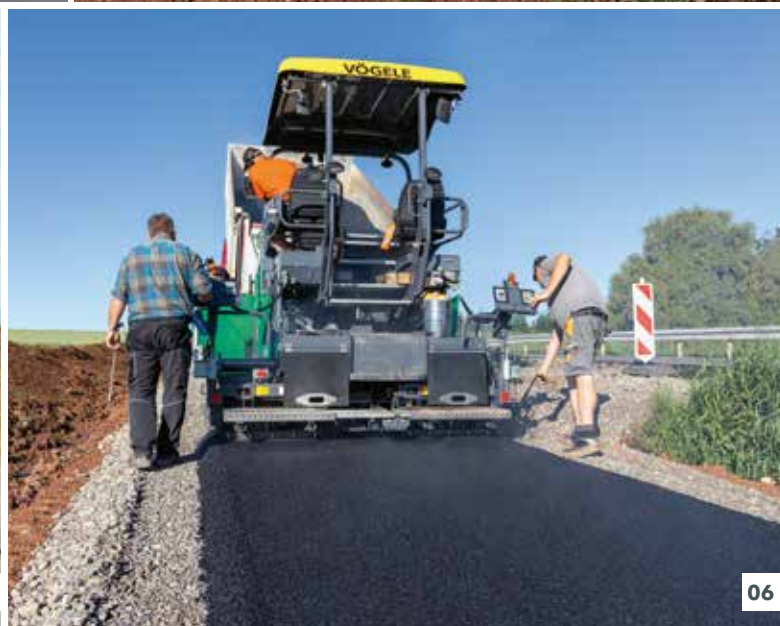
04 L'organisation du poste de conduite assure une excellente vue. 05 Alimentation optimale grâce à la grande trémie réceptrice. 06 Peut être combiné avec la table extensible AB 340.
