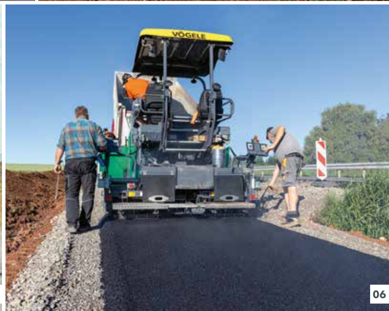
04 机手驾驶台, 使操作人员拥有理想的视野。 05 大型料斗, 实现理想喂料。 06 装备 AB 340 液压伸缩式熨平板。
